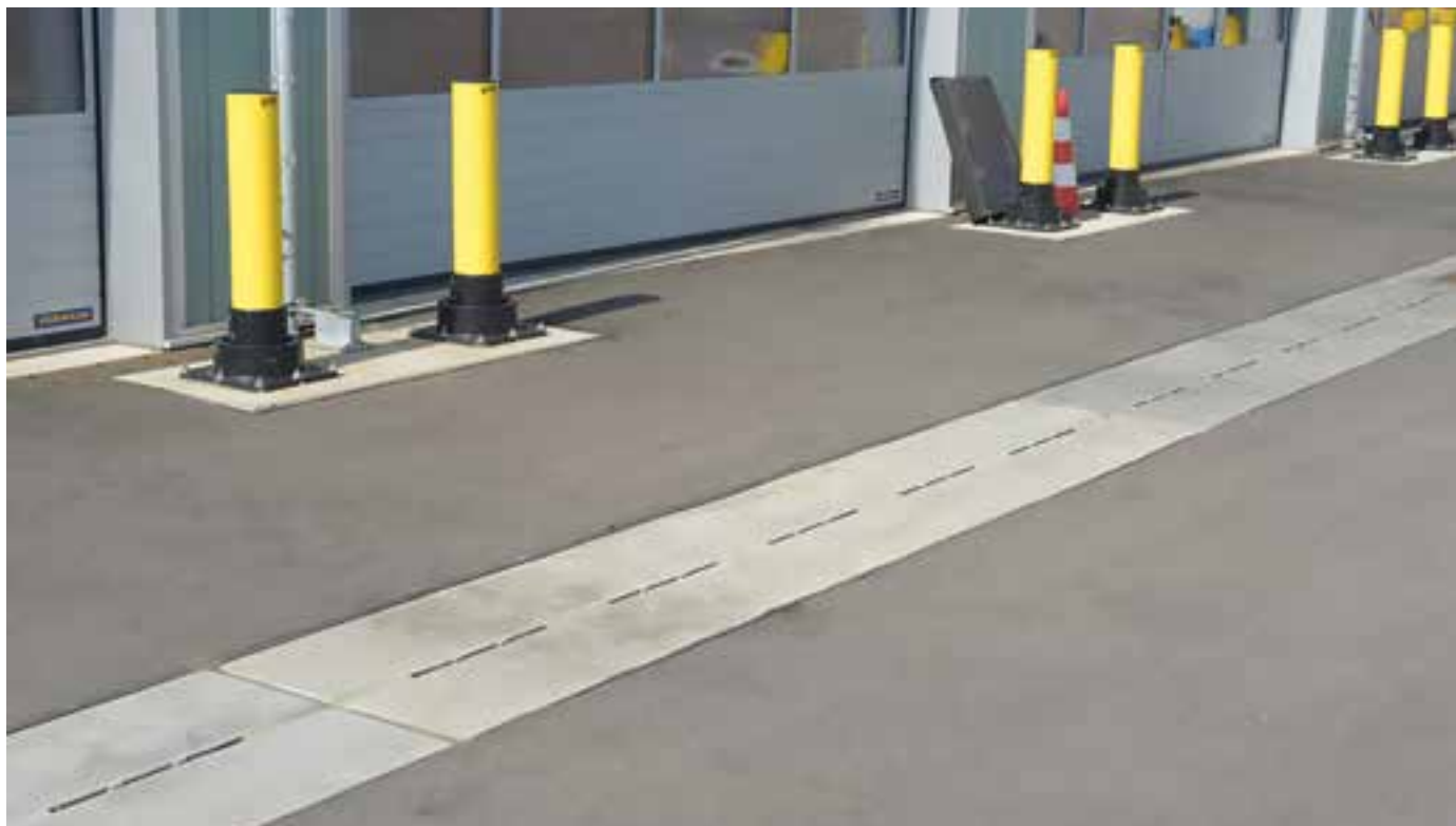
Einbau der ACO Pfuher Retentionsrinne – Profil 50 R auf Schwerlastflächen wie Busbetriebshöfen
