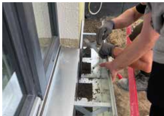
Montage des MEATEC-RV-Elements im Bereich eines bodentiefen Türanschlusses
