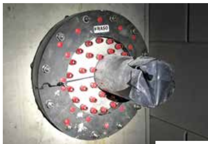
KRASO Dichteinsatz Typ SD-E (exzentrisch) und KRASO Kunststoffflanschplatte Typ KFP – geteilt – im Zusammenspiel zur Abdichtung vor der Wand
