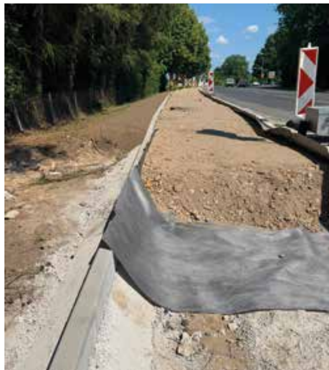
Rootprotector verhindert unerwünschten Wurzeldruck
