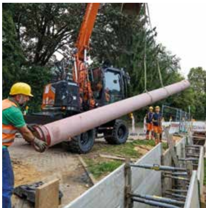
Leichlingen Rohreinbau
