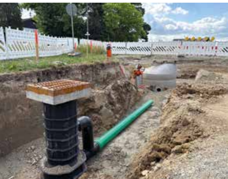
Referenzobjekt in Kötz (Bayern): Einbau des SSA in einem Neubaugebiet zur Vorbehandlung für die Niederschlagsversickerung
