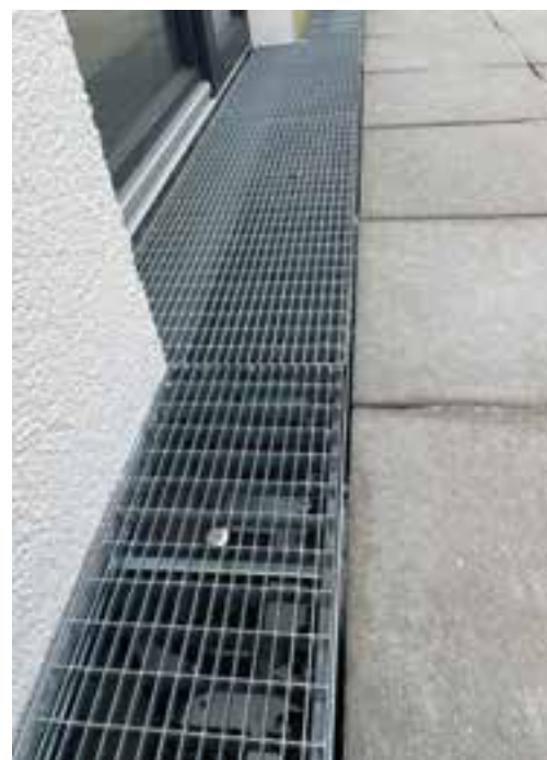
Barrierefreiheit durch niveaugleichen Übergang in den Belagsaufbau und zusätzliche Sicherheit durch Rostsicherung
