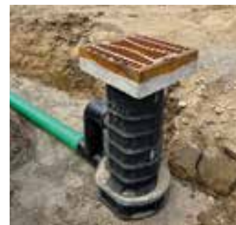
Als Basis für den SSA dient der ACO Combipoint PE Ablauf
