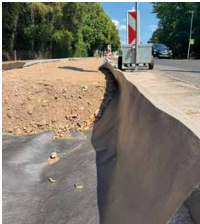
Einbau von Rootprotector in Guben
