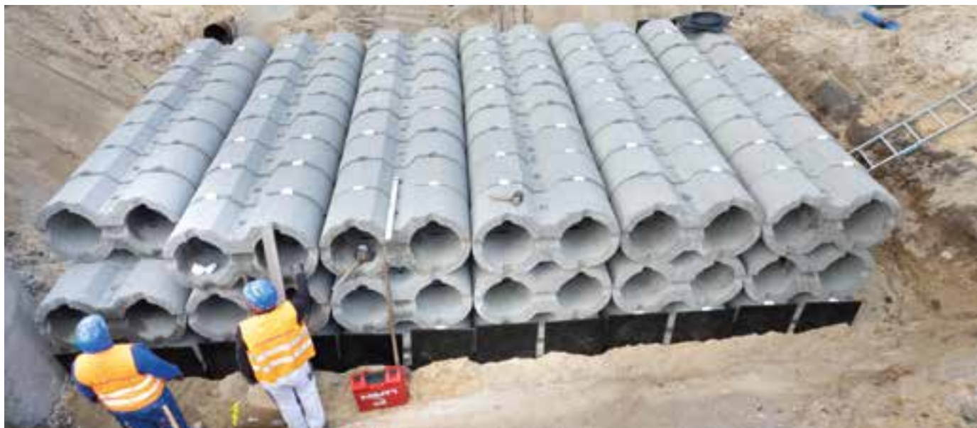
Mit den neuen Sickererelementen lassen sich flexibel auf die örtlichen Gegebenheiten angepasste Versickerungsanlagen realisieren (Mall GmbH)
