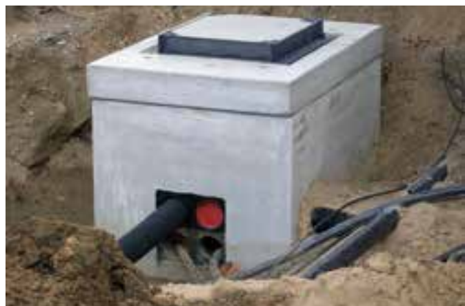
Monolithischer Kabelschacht aus Beton mit individuellen Rohranbindungen
