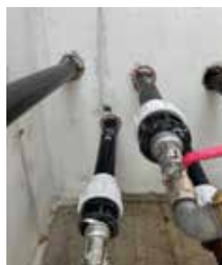
KRASO Dichteinsätze zum direkten Einsatz in der Kernbohrung
