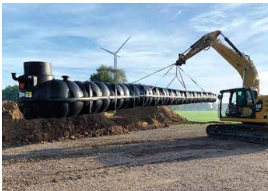
Einfaches Handling: Die PE-Flach tanks NEO lassen sich einfach mit einem Aushubagger transportieren und benötigen nur eine flache Baugrube (Fotos: Premier Tech Water and Environment GmbH)
