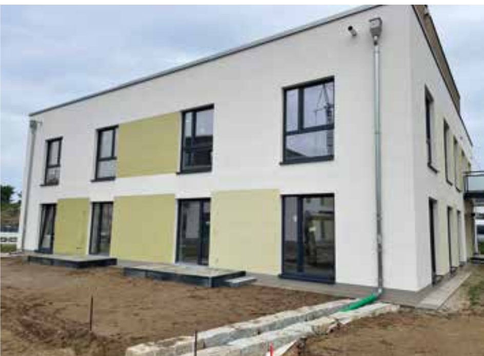
Teil des Neubauprojekts in Berlin-Mahlsdorf mit insgesamt 35 Mehrfamilienhäusern und 248 Wohneinheiten
