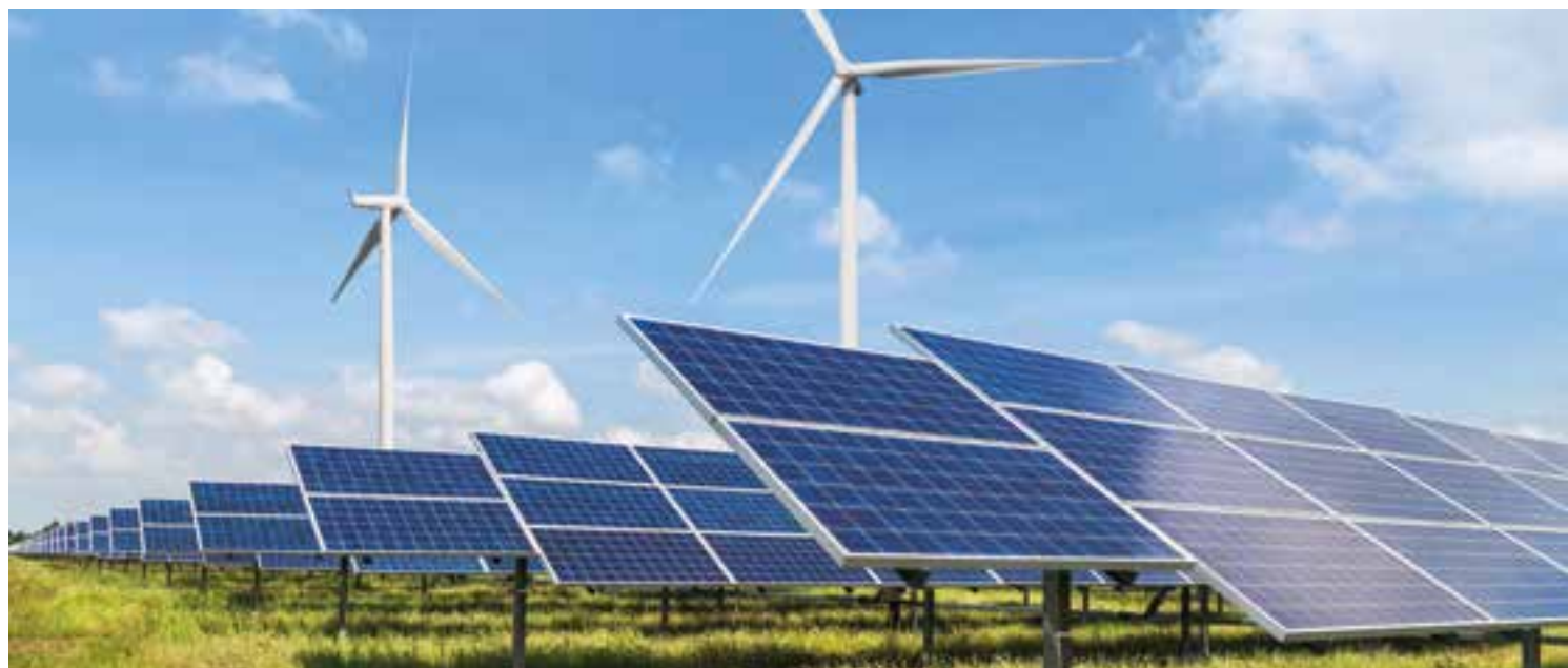
Großflächige Photovoltaikanlage mit ca. 24.500 m HEKASOL Kabelschutzrohr
