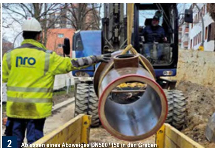
2 Ablassen eines Abzweiges DN500/150 in den Graben
