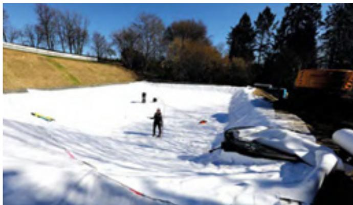
Eingebautes Abdichtungssystem aus TPD und Schutzlagen
