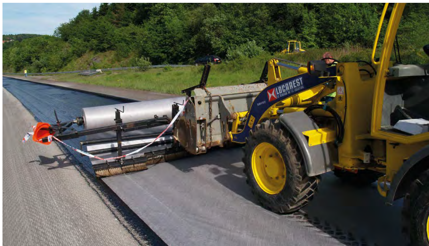
Einfache und wirtschaftliche Verlegung der MIRAGRID PGM Asphalteinlage
