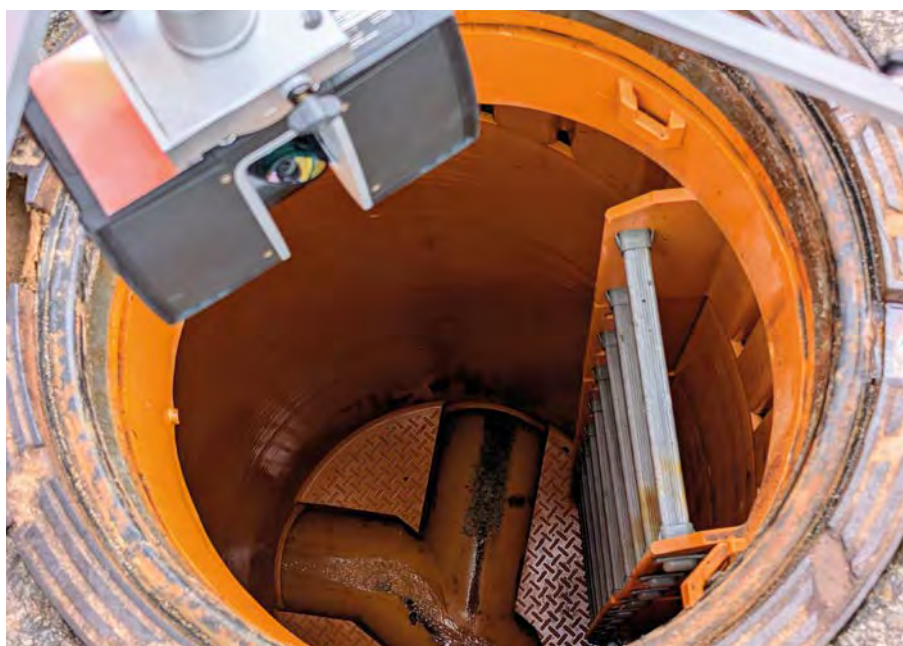
REHAU Schächte werden individuell konfektioniert – für einfachen Einbau, dauerhafte Kosteneffizienz und bis zu 100 Jahren Lebensdauer
