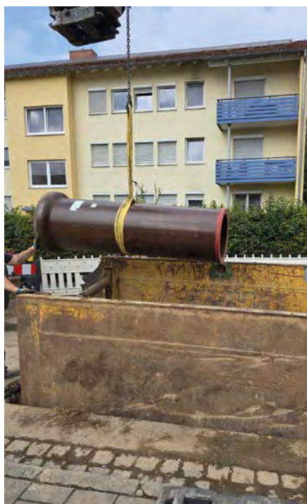
Ablassen eines Rohres DN500H in den Graben
