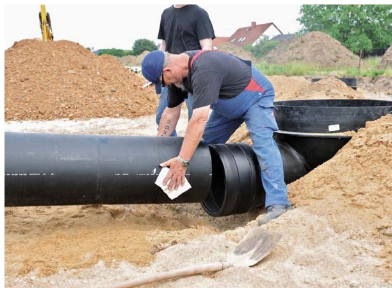
Baustellensichere Montage: PE-Rohrverbindung mit Elektroschweißmuffe
