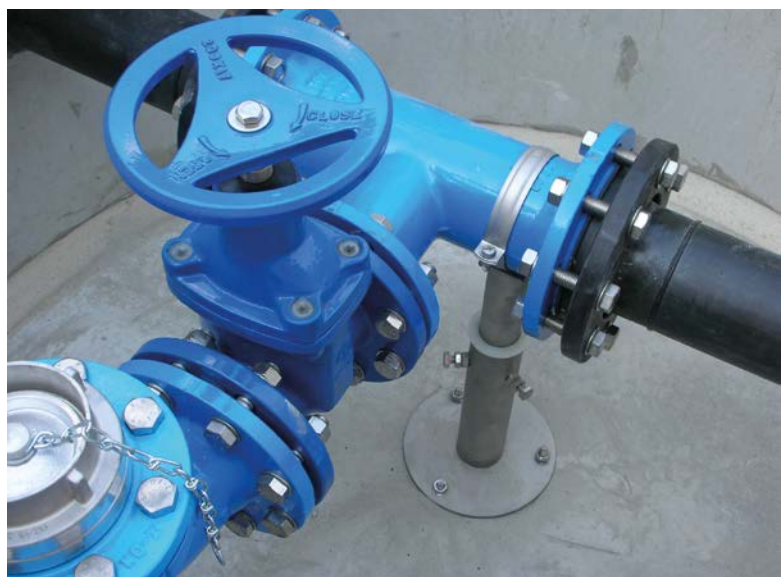
Der Mengemessschacht wird als komplett vormontierte Einheit geliefert. Foto: Mall GmbH
