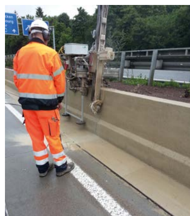
Fugenausbildung an Betonschutzwand
