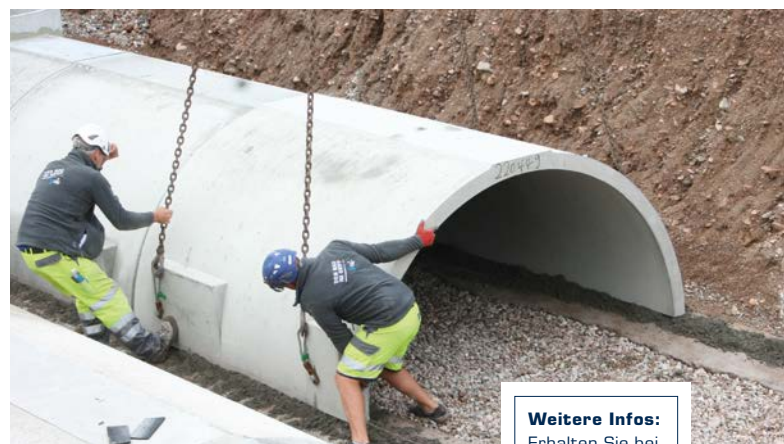
Das erste Bauteil des Sickertunnels wird in der Baugrube platziert. (Mall GmbH)
