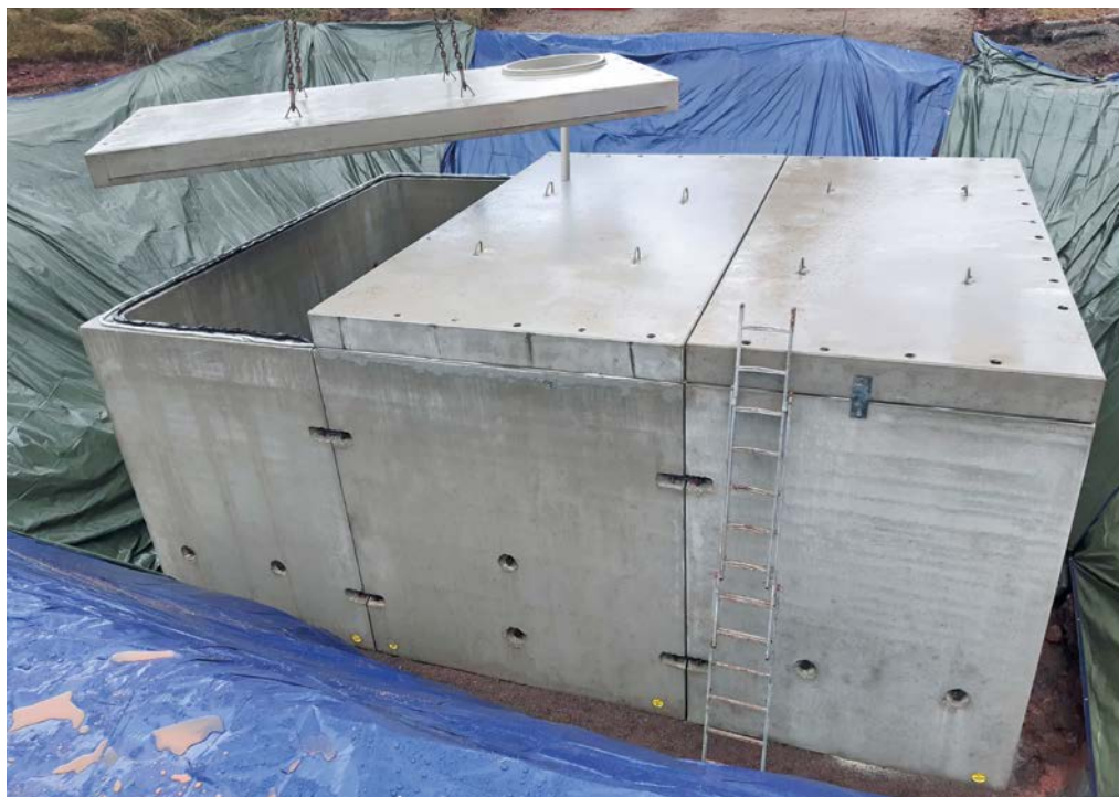
Dank werkseitiger Vorfertigung konnte das Bauwerk binnen eines Tages in Unterlengenhardt (Bad Liebenzell) montiert werden.
