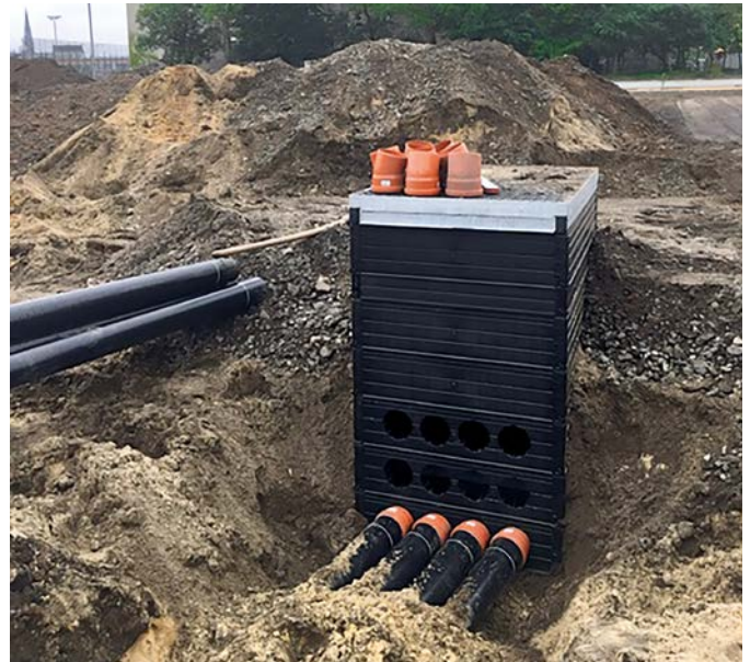
ROM-Box: Modular aufgebaut für mehr Flexibilität
