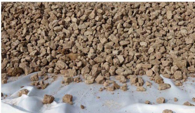
Baustraße, ungebundener Oberbau bewehrt mit PET-Hochlastgewebe
